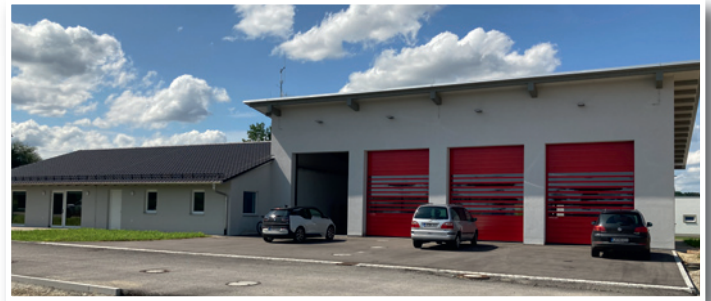
Neubau des Feuerwehrgerätehauses in Gündlkofen Baukosten: 2,2 Mio EUR
